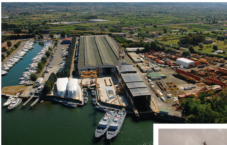
Cantiere di Sarzana (SP)
